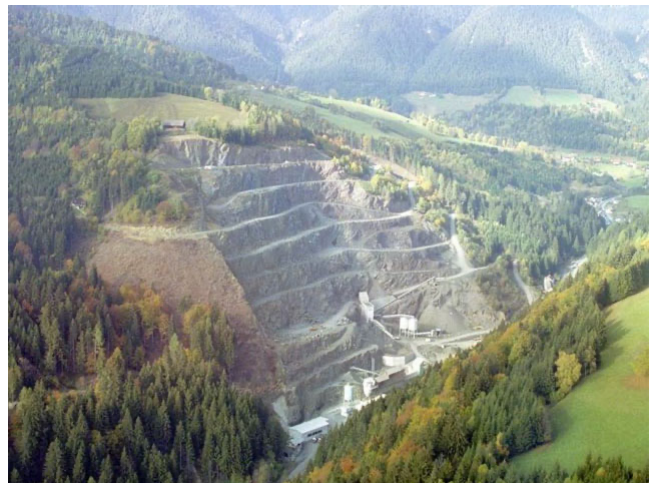
Abb. 1: Blick auf den Jakoministeinbruch und die Aufbereitungsanlage
