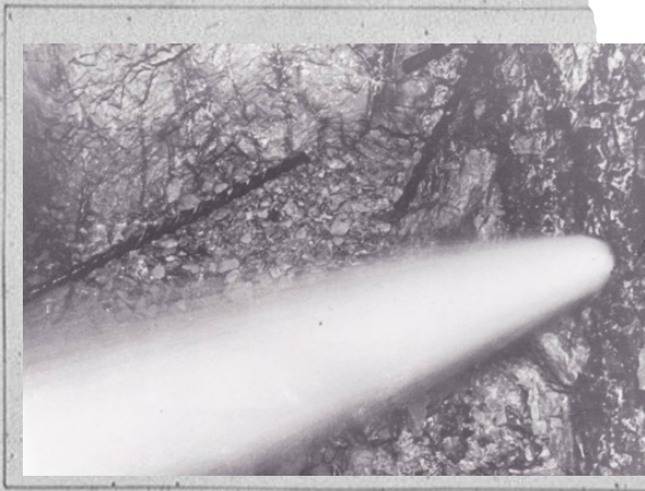
Ortsbrust mit einbrechendem Thermalwasserstrahl Rüdolfeschacht 12 Lauf
