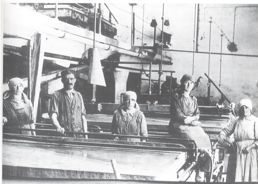
Abb. 3: Herdarbeit in der Zentralaufbereitung Antonischacht (Werksfoto)
