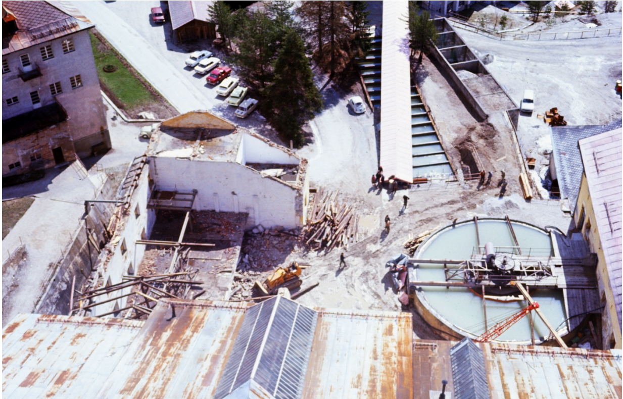
Abb. 8: Abbruch der nördlichen nassmechanischen Abteilung während die Flotation in Betrieb steht (zu erkennen am gefüllten Rundeindicker)
