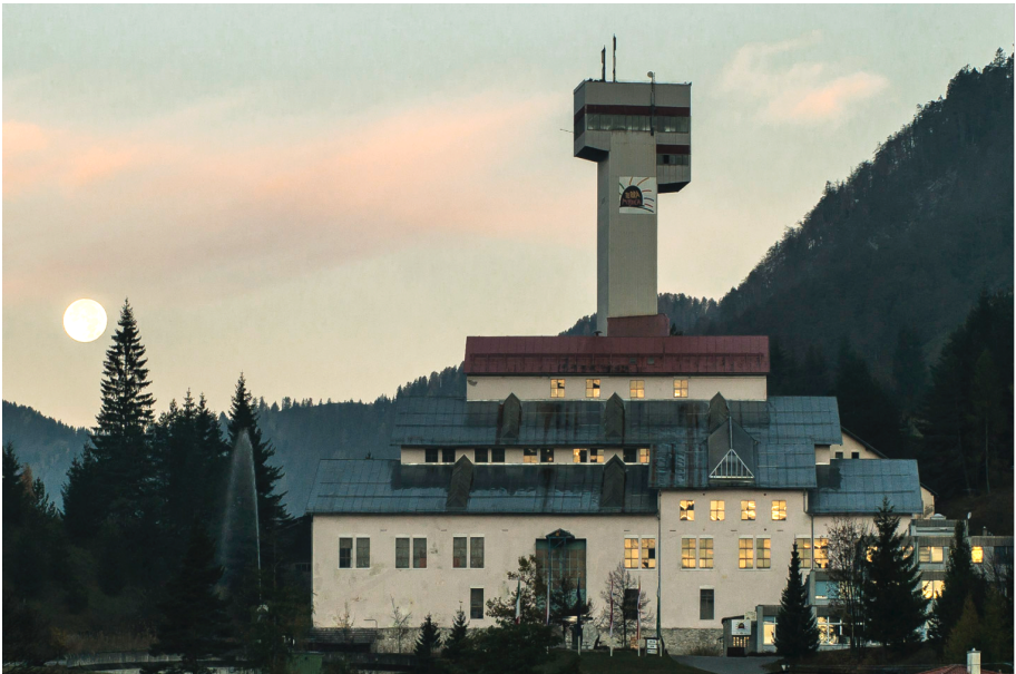
Abb. 2: Hauptförderturm und ehem. Zentralaufbereitung „Antoni“
